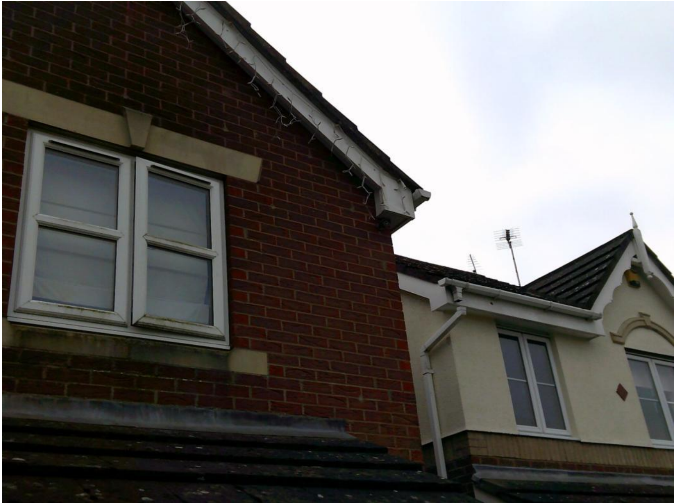
Boxes UPVC soffits (over clad)
