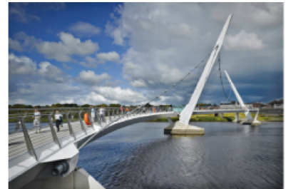
Peace Bridge, Derry-Londonderry
