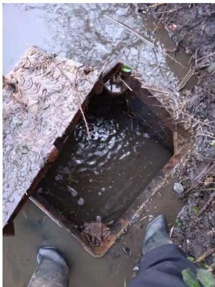
1 pipe visible MH top corner i.JPG
