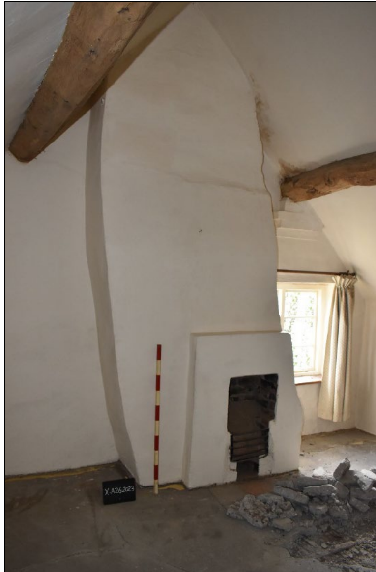
Plate 48: SF04 looking ESE (1.0m scale)
