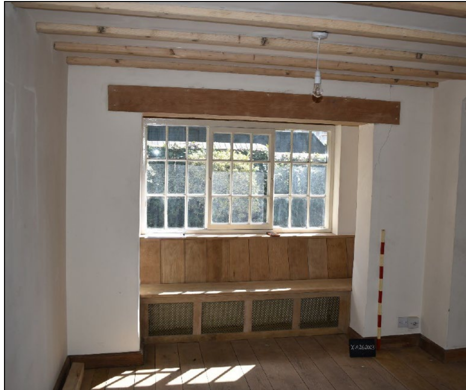
Plate 20: GF04 looking ESE (1.0m scale)
