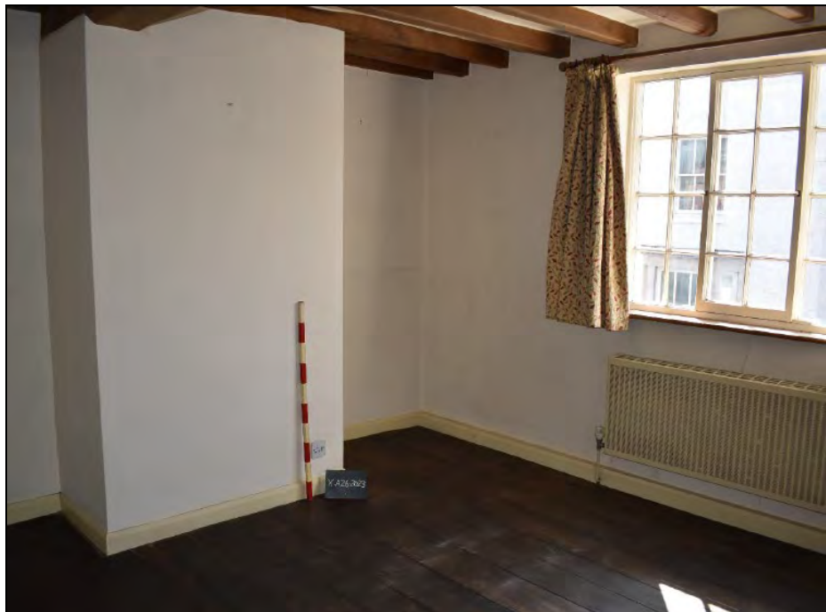
Plate 40: FF05 looking SE (1.0m scale)
