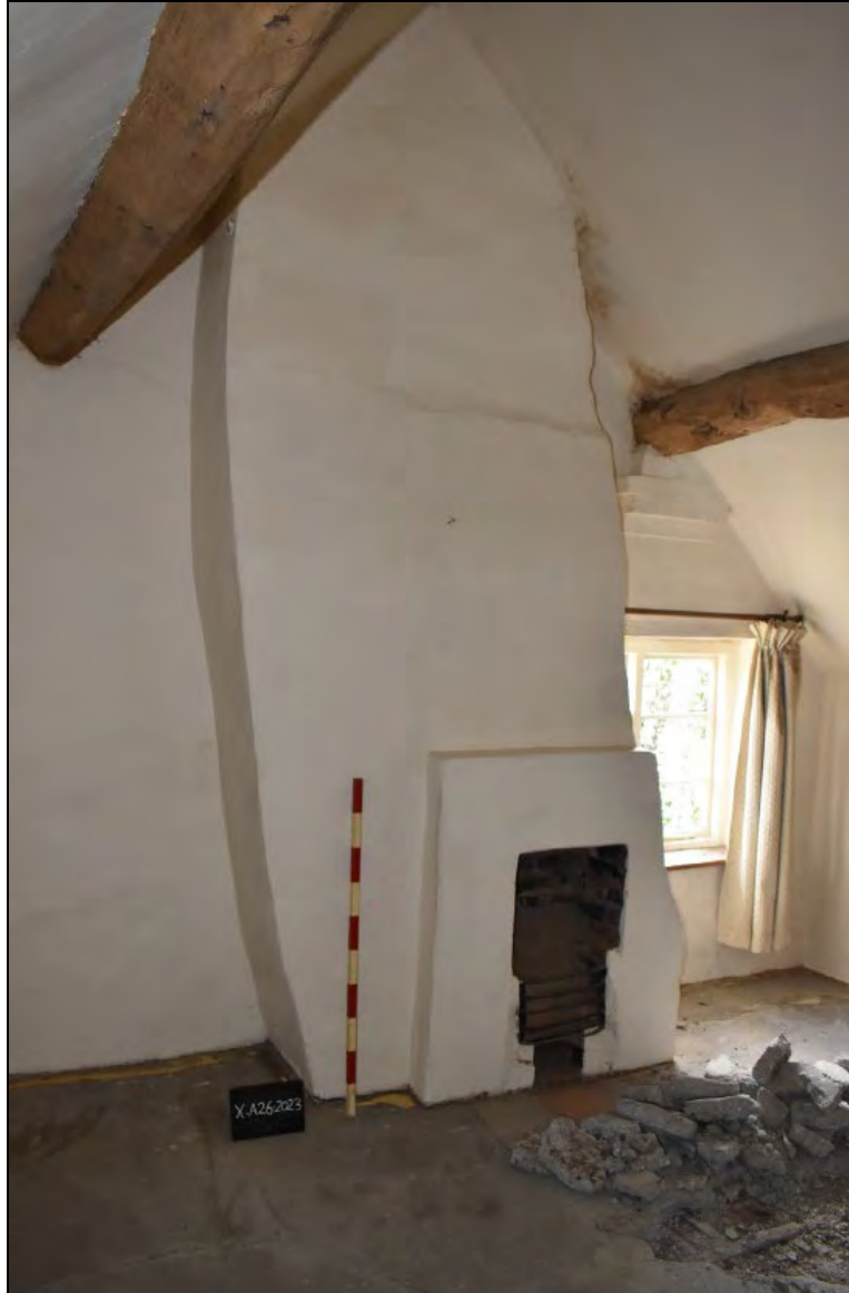
Plate 48: SF04 looking ESE (1.0m scale)
