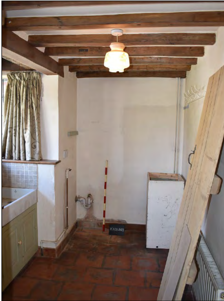
Plate 19: GF03 looking ESE (1.0m scale)
