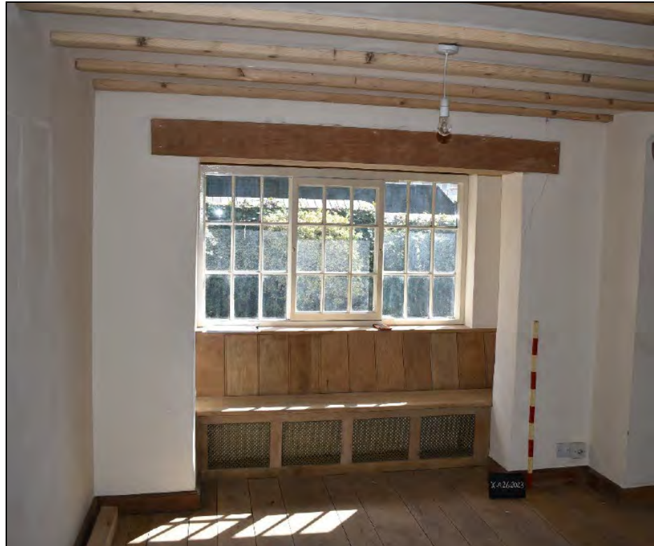
Plate 20: GF04 looking ESE (1.0m scale)
