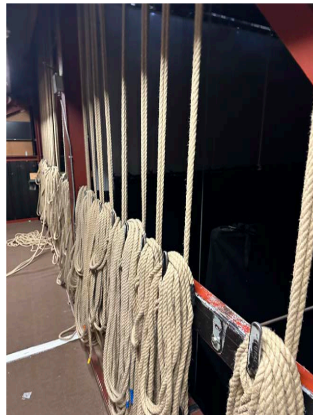
Flytower : Flyfloor & Hemps
